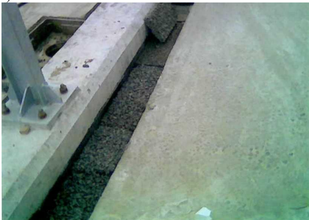
Схема 2 Образование дренажного канала:
