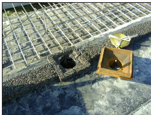
Схема 3 Дренажные брикеты «Козинаки ® » – трубка
