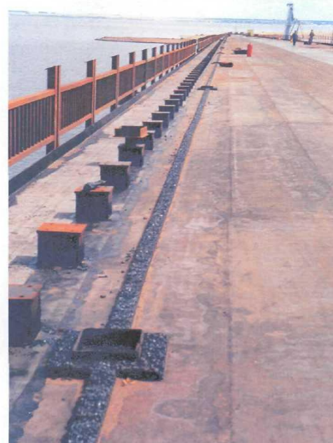
Схема 5 Сопряжение дренажного канала с водоотводными трубками на ортотропной плите
